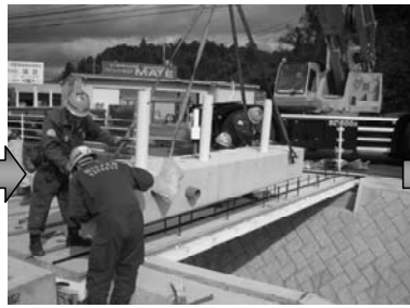
プレキャスト地覆設置
