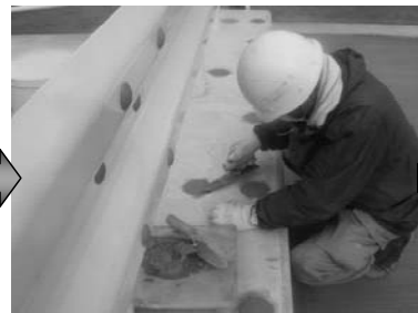
打設孔仕上げ
