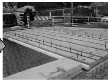
PC桁架設完了
