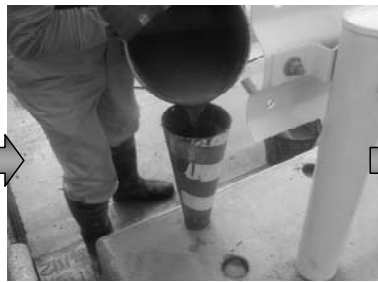
無収縮モルタル打設
