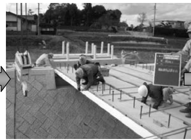
横組鉄筋設置
