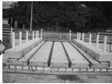
プレキャスト地覆設置完了
