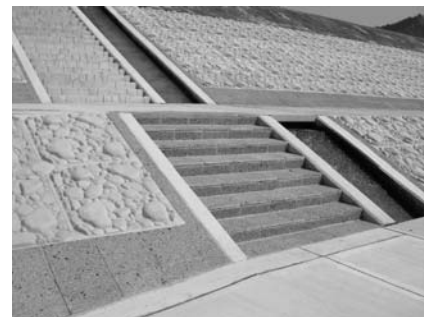
写真-7 KC 板 護岸整備 (国土交通省)
