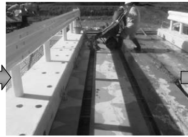
間詰めコンクリート打設
