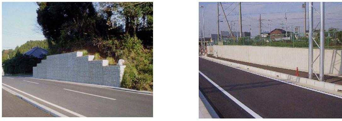
写真 - 1 鋼矢板による擁壁の実施例
