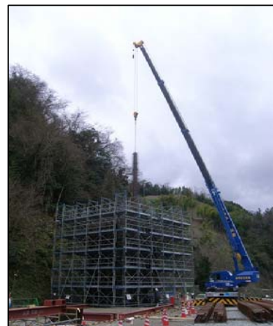
スパイラルカラム建込み状況
