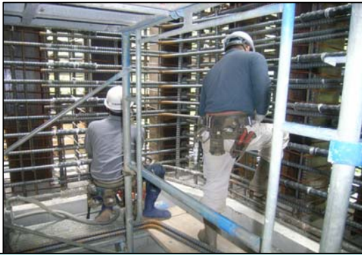
鉄筋組み立て状況
