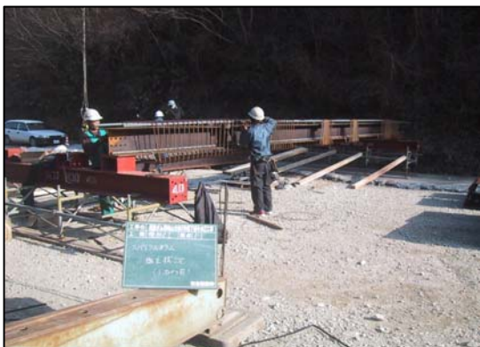
スパイラルカラムの接合状況
