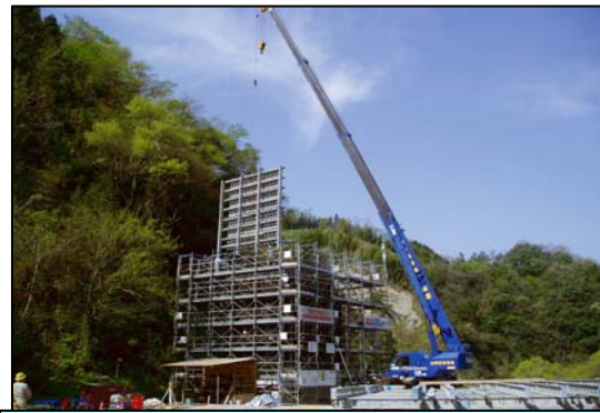
大型パネル型枠建込み状況
