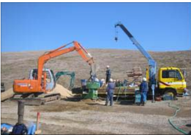
写真-2 材料混合状況
