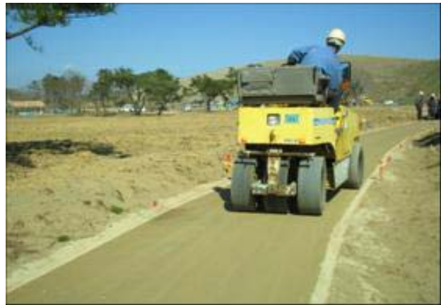
写真-3 転圧状況
