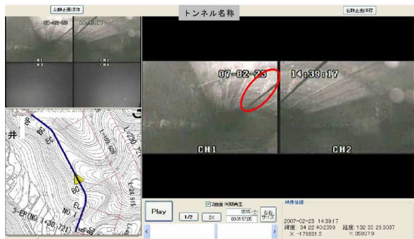
写真－5 報告書の劣化損傷を示す写真 (左下：平面位置 右：気中拡大映像)
