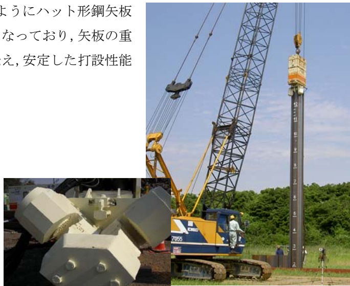
写真-2 ハット形鋼矢板900専用チャック装置
