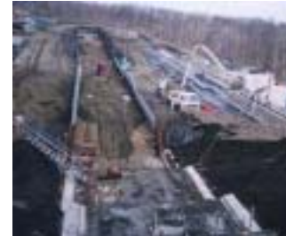
写真6 三宅島DWの急速施工事例
