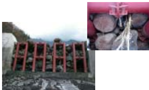
写真4 雄忠志内川3号えん堤
