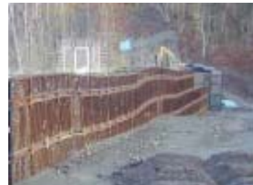
写真8 軟弱地盤(有珠山)での施工事例
