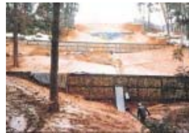
写真7 地すべり地域での設置事例
