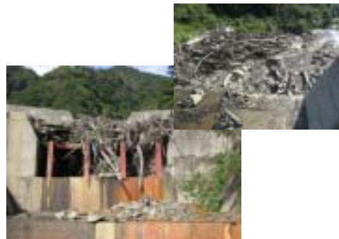
写真2 中俣川流木捕捉工
