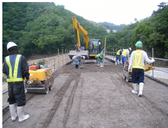
写真②：CSGコンクリート打設の施工状況
