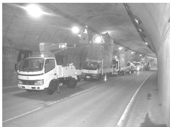
写真 - 1 トンネルの裏込注入
