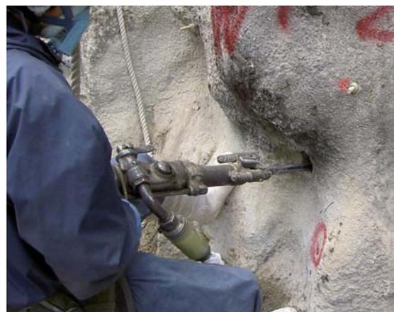
図-6 鉄筋挿入工写真(削孔)
