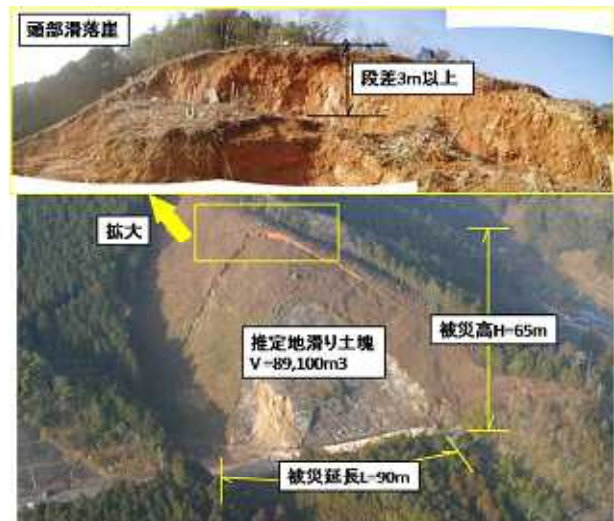
写真 1 地すべり全景と頭部滑落崖
