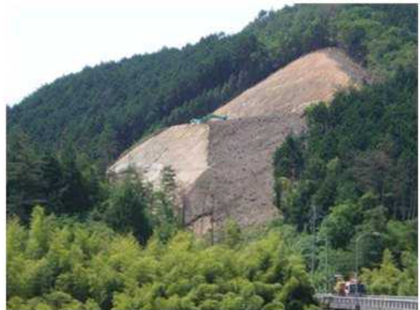
写真 6 頭部排土工完了後
