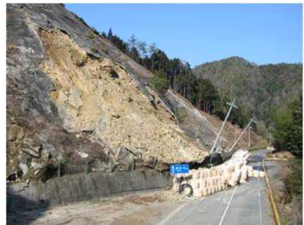
写真 2 末端部表層崩壊と擁壁の押出し
