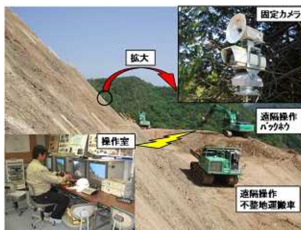
写真 3 頭部排土工(掘削・積込・運搬)
