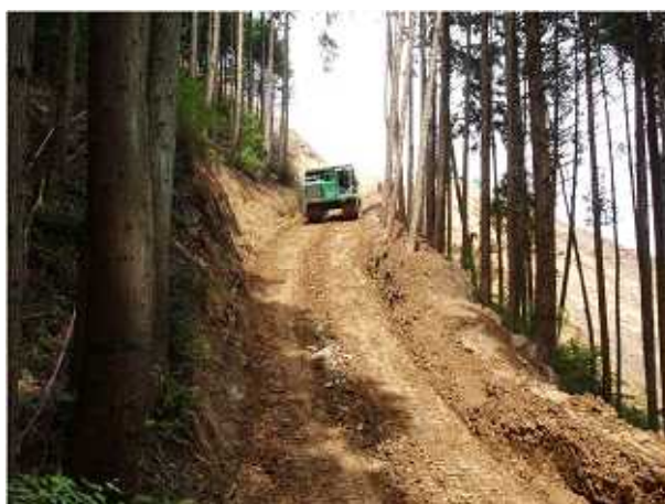
写真 4 掘削土小運搬工(有人区域)
