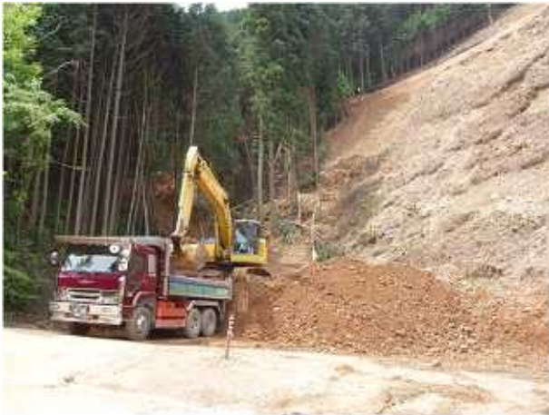
写真 5 掘削土搬出状況
