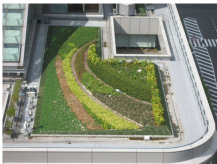
写真-1 薄層緑化システム 適用事例
