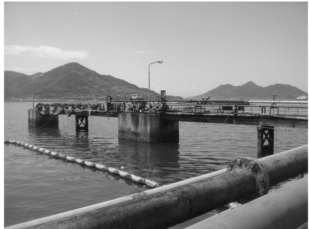
写真-1 既設栈橋状況
