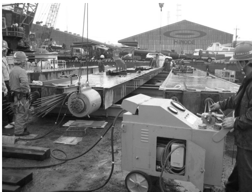
写真-4 緊張作業状況
