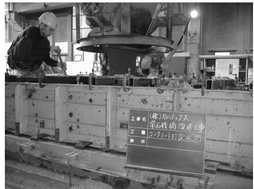
写真-3 打設状況
