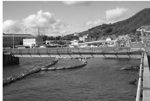
写真-7 完成状況
