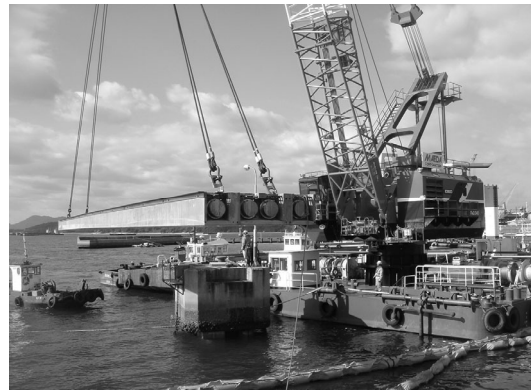
写真-5 主桁架設状況
