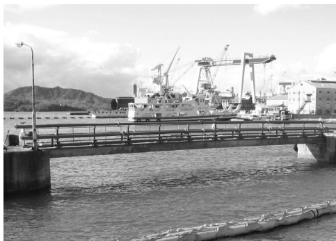
写真-6 完成状況
