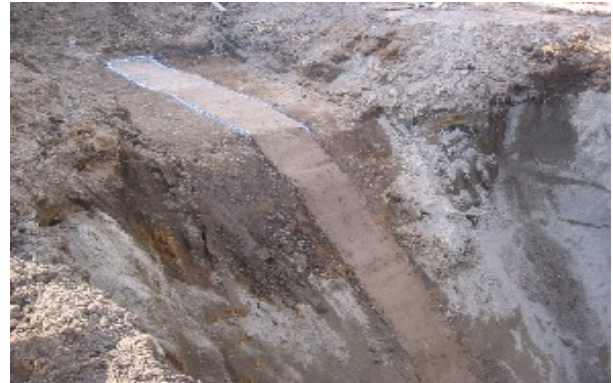
写真-1 ECウォール出来形断面
