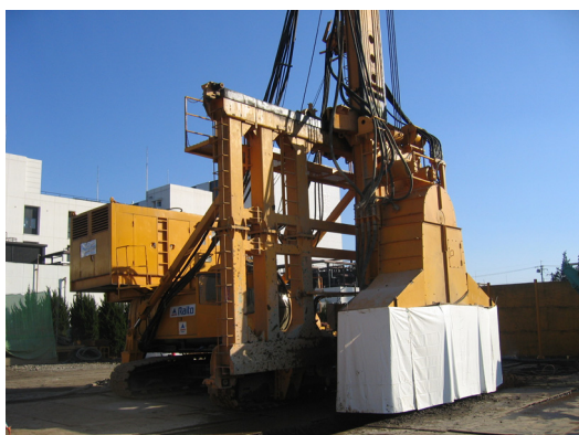
写真-2 等厚式施工機
