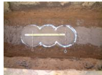
写真-5 柱列式の出来形
