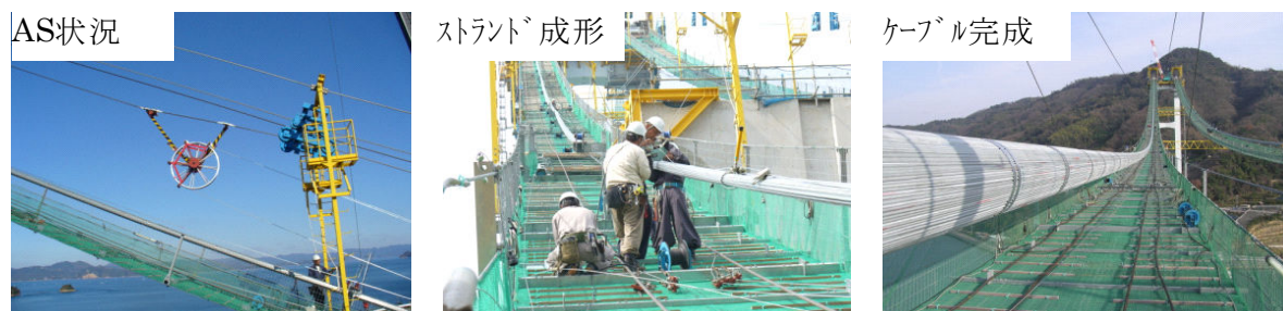
図-6 ケーブル架設状況写真
