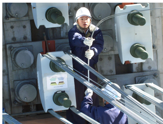
図-7 ハンドリング作業状況
