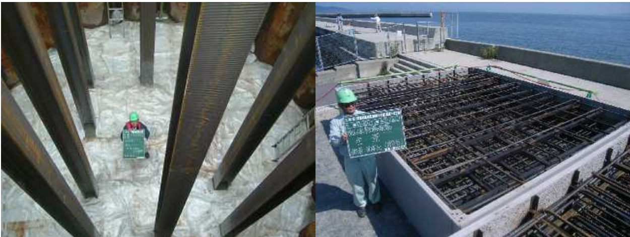
突起付き H 型鋼建て込み
