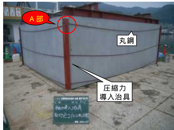
図-7 圧縮力導入治具
