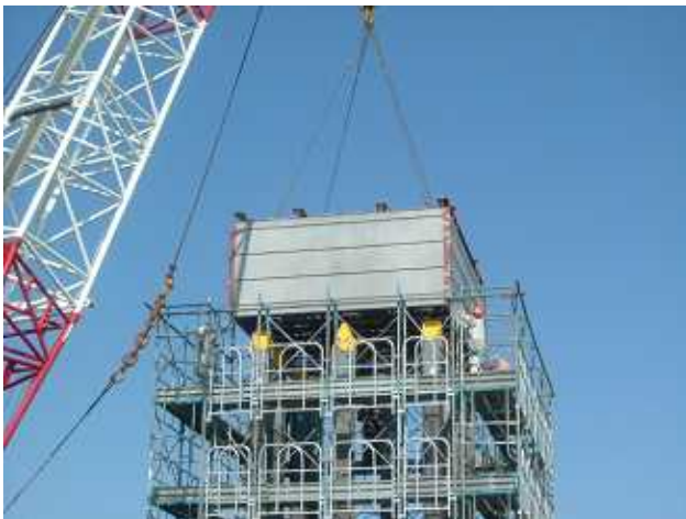
起重機船を使用しての据付
