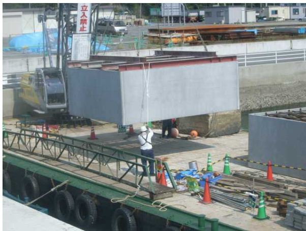
図-6 吊り枠使用状況
