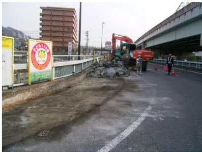
写真 3.3 既設歩道の撤去状況
