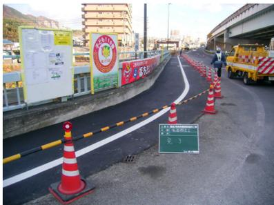
写真 3.4 施工中の通行帯確保
