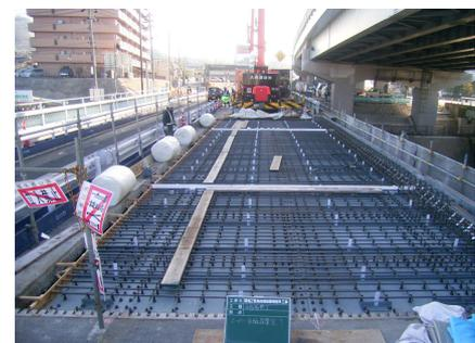
写真 3.2 スーパー床版の設置完了
