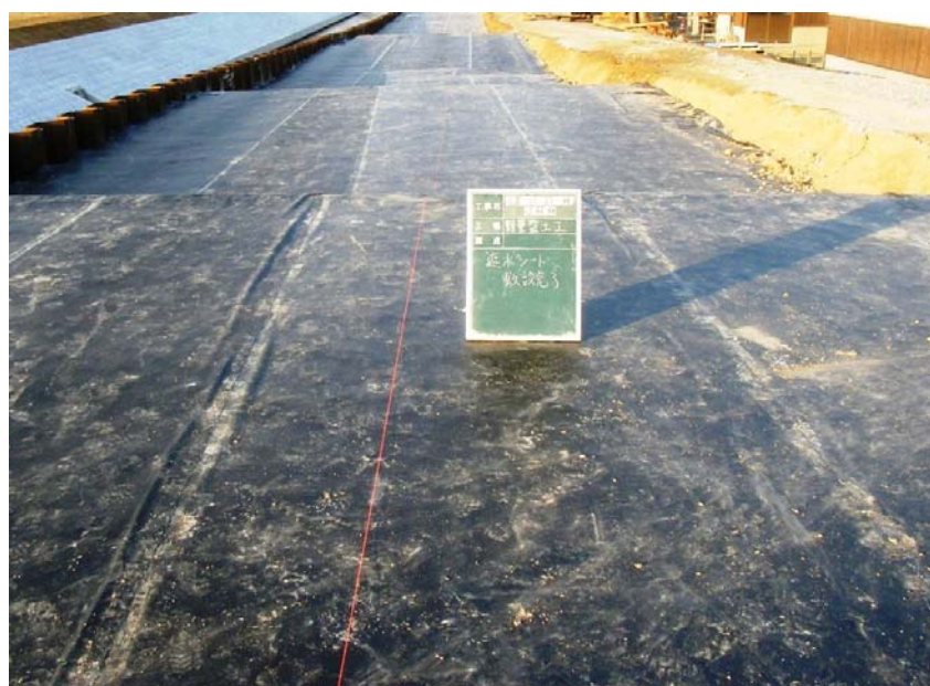
図-9 施工完了（天端遮水シート完了）
