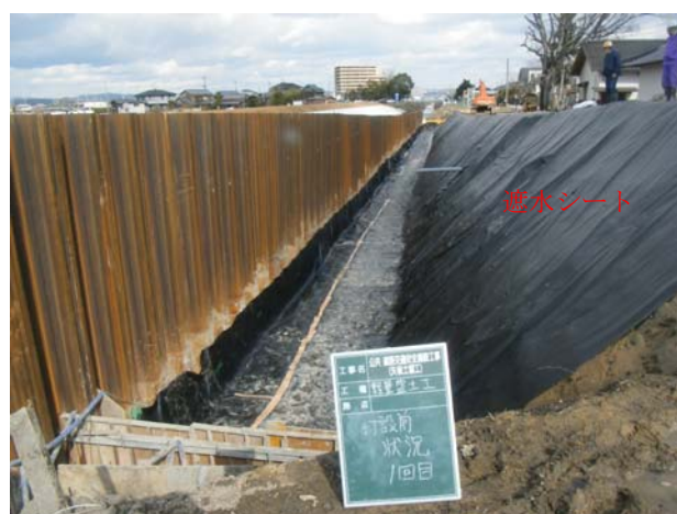
遮水シート敷設
