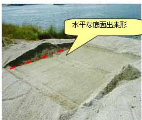
図 8 : SGB による掘削面
