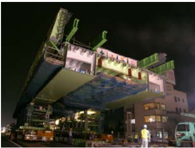
写真-2 移動多軸台車による 一括架設状況
