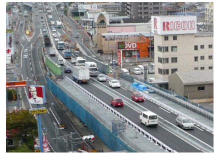
写真-4 暫定2車線供用状況
