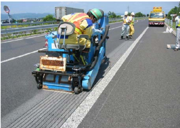
写真-1 グルーピング設置状況
