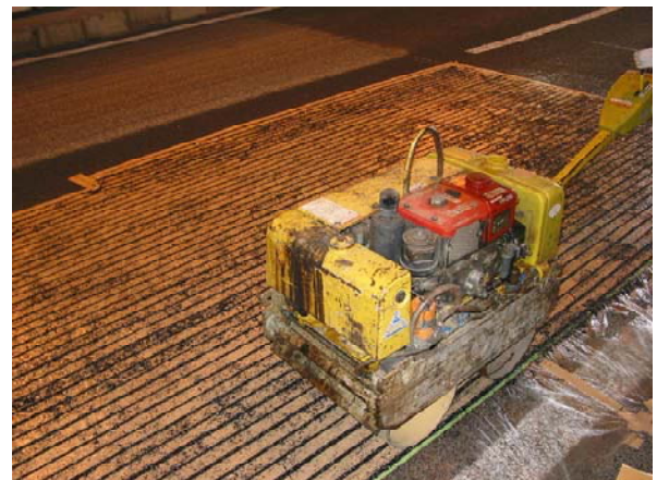
写真-4 表面の不陸整正状況
