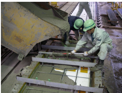
④コンクリート打設
