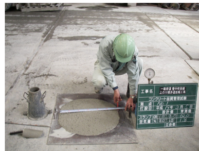
⑤コンクリートの品質管理
