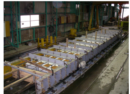
③型枠組立
