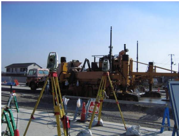
写真-9 施工状況
