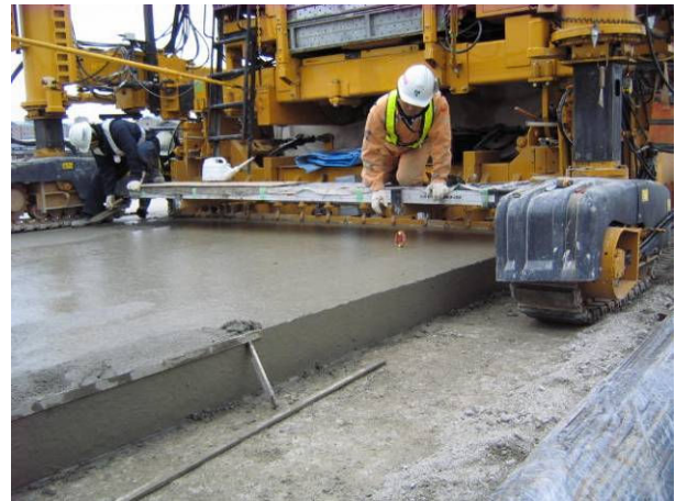
写真-10 出来形測定状況
