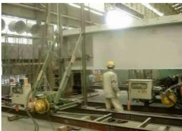
図-11 溶射作業の状況(機械施工)
