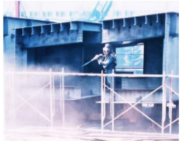
図-9 プラスト作業(1種ケレン同等作業)
