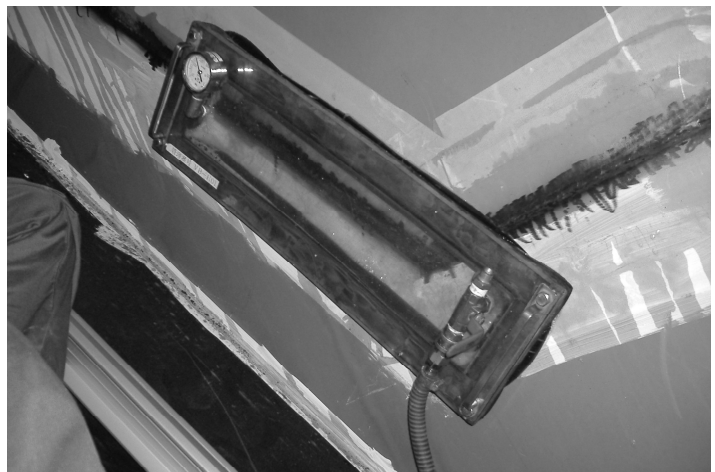
写真-1 発泡漏れ試験状況
