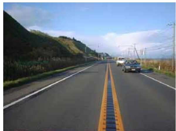
写真-1 ランブルストリップス設置状況
