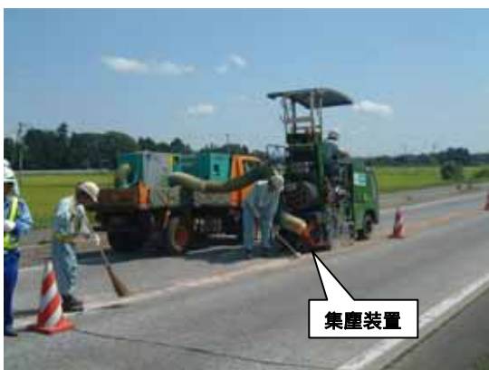
写真 - 6 コンクリート舗装路面施工状況(対策後)
