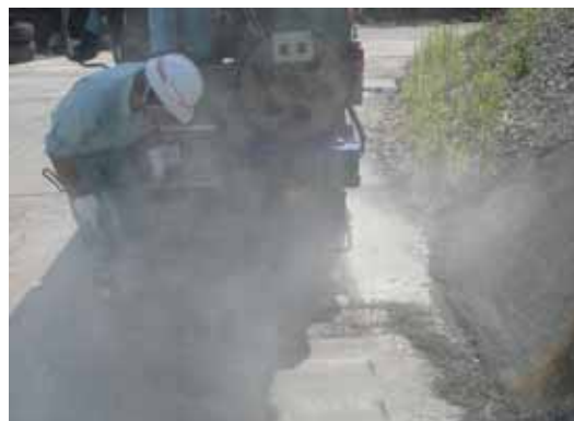
写真 - 5 コンクリート舗装路面施工状況(対策前)
