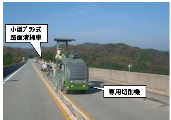
写真-3 密粒舗装路面施工状況
