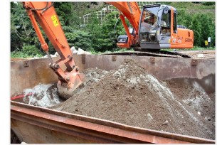
写真-6 バックホウ攪拌混合状況
