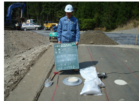
写真-4 現場密度試験
