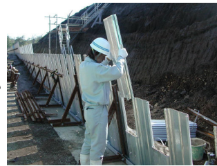
写真-8 外部保護材の施工状況
