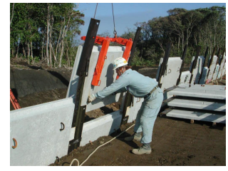
写真-8 外部保護材の施工状況
