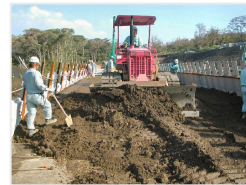
写真-7 敷き均し・締め固め状況
