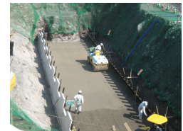
写真-7 敷き均し・締め固め状況
