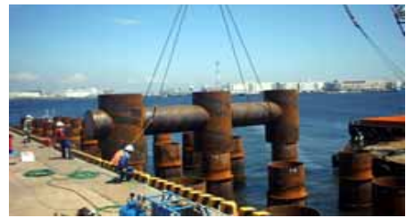
写真 - 1 既設栈橋補強事例 1
