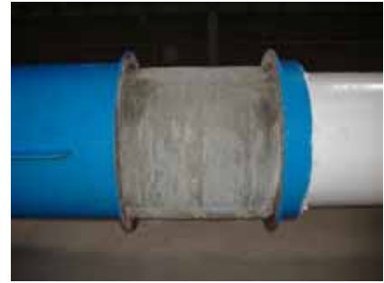
写真-4 グラウト充填確認
