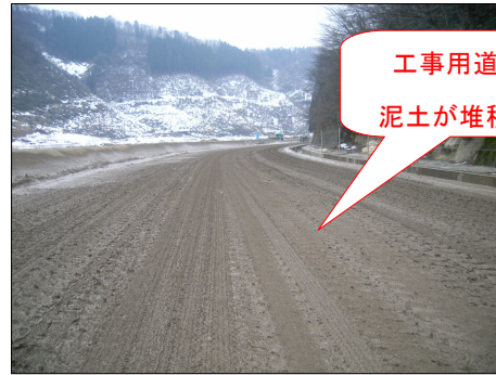
写真②：工事用道路上の泥土汚損状況
