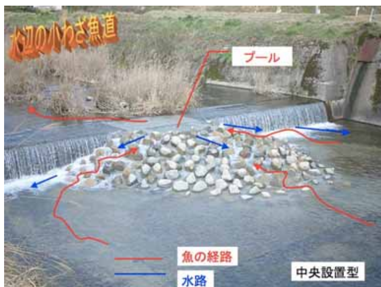
図 1 . 水辺の小わざ魚道（中央設置型）.
