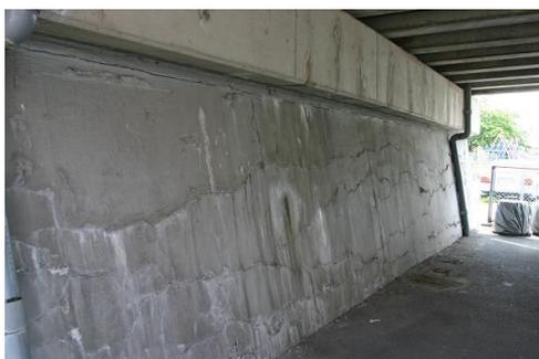
写真-1 ASRにより劣化したコンクリート橋台
