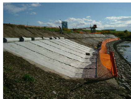
写真-1 吸出防止材の設置
