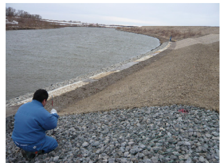
写真-6 光波測距計による測量状況
