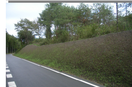
写真-16 施工後1ヶ月(10月)
