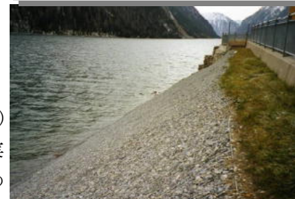
写真-19 施工完了
