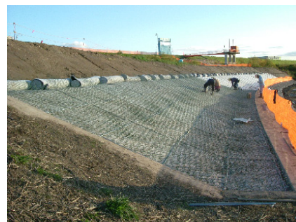
写真-2 3Dパネルの設置
