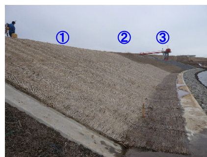
写真-4 施工完了
