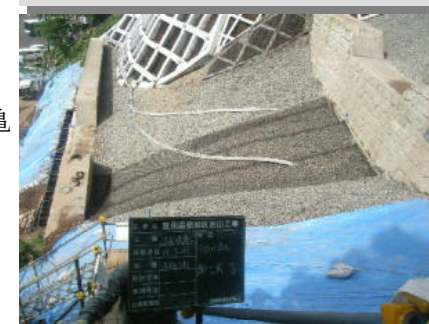
写真-18 施工完了
