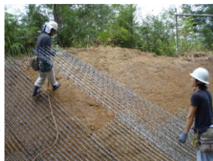
写真-15 パネル設置状況
