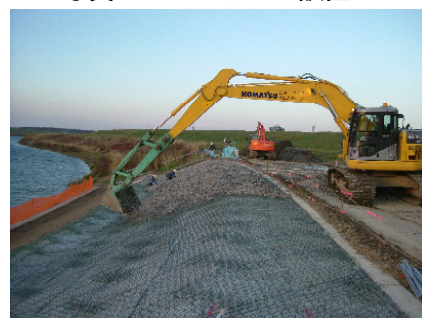
写真-3 碎石の投入
