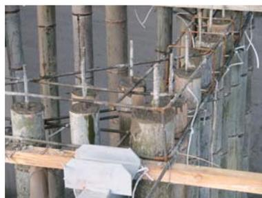
竹筒内に鉄筋を配置し、モルタルを充填
