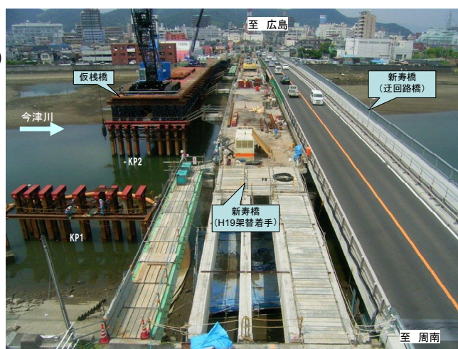
写真-1 工事状況(H20.8撮影)
