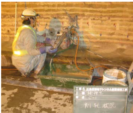
写真-2 ダイヤモンドコアマシーン削孔状況
