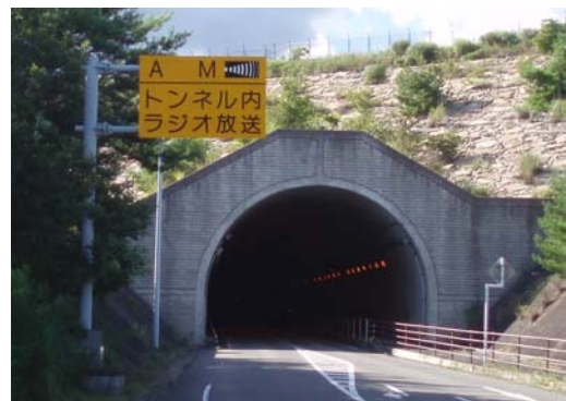
写真-1 用倉トンネル
