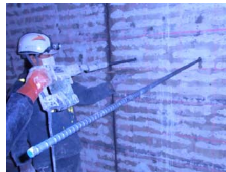
写真-4 鉄筋挿入状況
