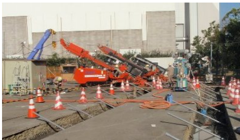
写真-2 カーボックス工法による削孔・注入管設置状況
