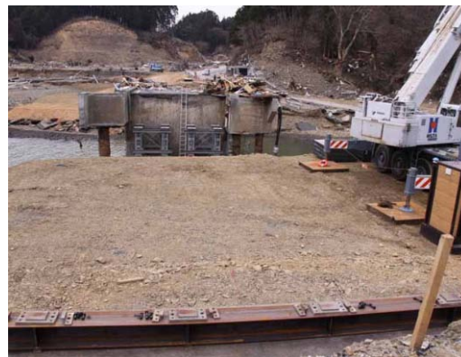
写真－10 仮橋脚設置(3月30日)
