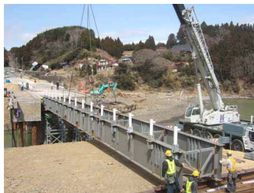
写真－12 仮橋の架設(4月1日)
