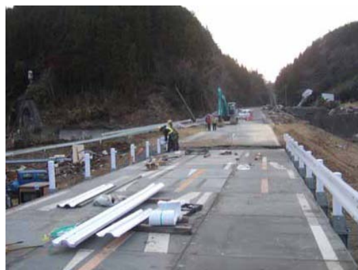
写真－13 橋面工の施工(4月2日)
