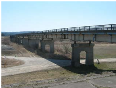
写真-15 単純ゲルバー鋼桁
