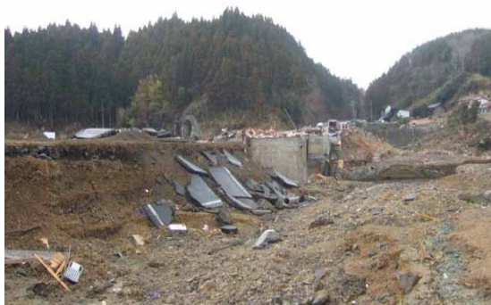
写真－8 国道45号 二十一浜橋の流出(3月22日)
