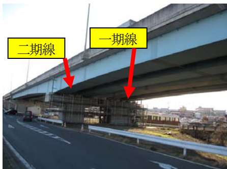
写真-21 一期線（鋼製沓）と二期線（ゴム沓）
