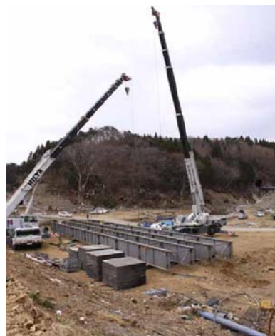
写真－11 仮橋の地組(3月31日)
