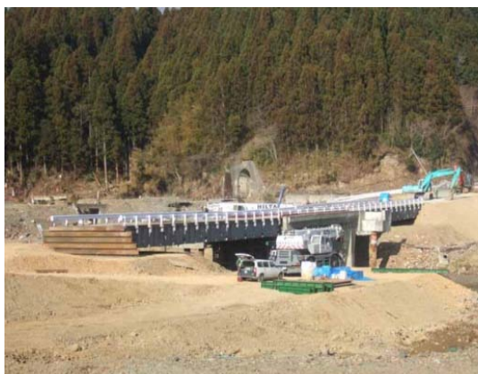
写真－9 国道45号 二十一浜橋の仮橋完成(4月4日)
