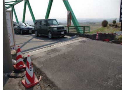
写真-17 単純トラス橋の段差補修
