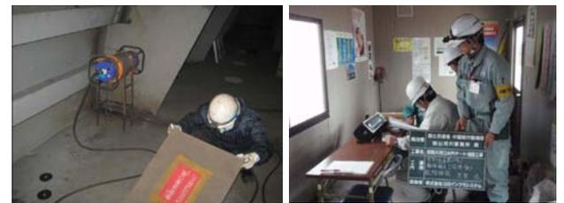
図-18 放射線透過検査の実施状況
