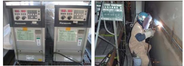
図-16 デジタル式CO<sub>2</sub>半自動溶接と溶接状況
