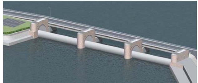
図-3 ライジングセクタゲートの鳥瞰図
