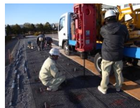
(c) 拘束部材の打込み
