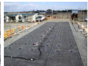
(f) 施工完了
