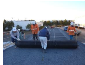
(a) 面状補強材の敷設
