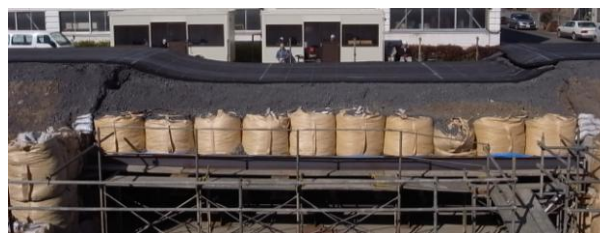
(a) 実物大性能確認実験状況（段差量55cm）
