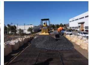
(b) 粒状材の施工
