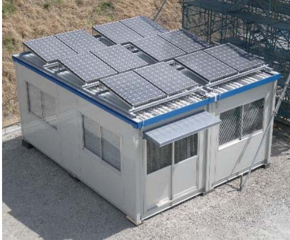
180wソーラーパネル×12枚(=最大2.16kw)
