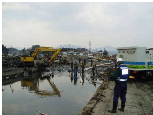
東松島市における排水ポンプ車、照明車の稼働状況
