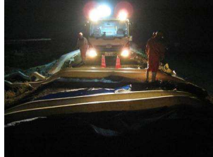
名取川(名取市)における排水ポンプ車稼働状況
