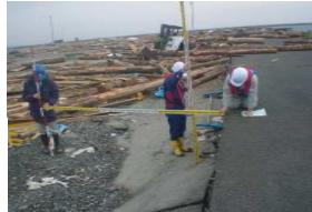
石巻港被害状況調査(港湾班)
