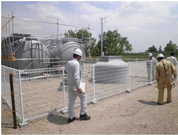
写真-7 福島市飯坂町福島北警察署での完成検査の様子（合併処理浄化槽の状況を検査）
