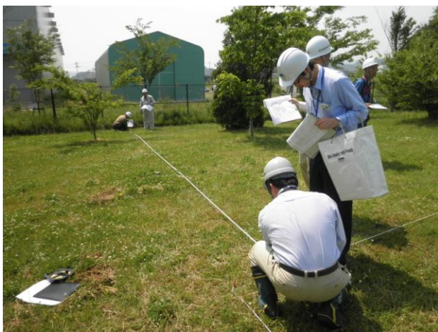
写真-3 本宮市恵向公園での地縄検査の様子 (建物の配置状況を計測・検査)
