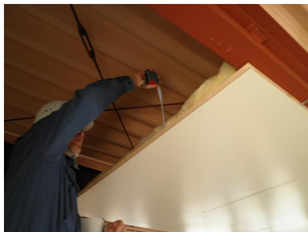
写真-4 二本松市杉内グランドでの中間検査の様子 (天井裏の断熱材施工厚さを計測)
