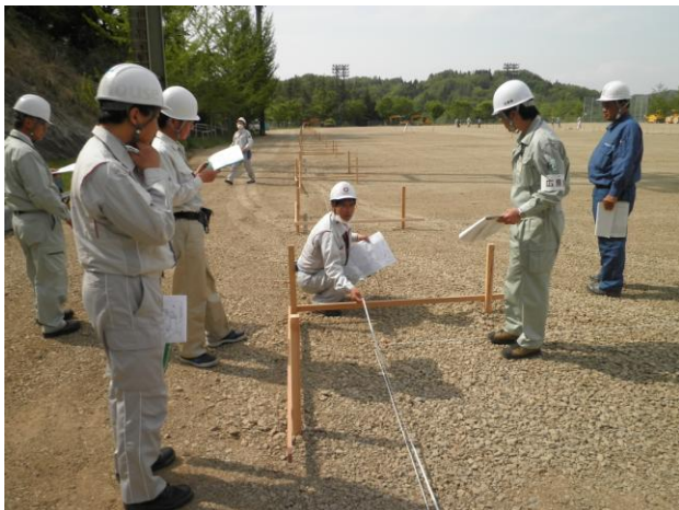
写真-2 川俣町農村広場での地縄検査の様子 (建物の配置状況を計測・検査)
