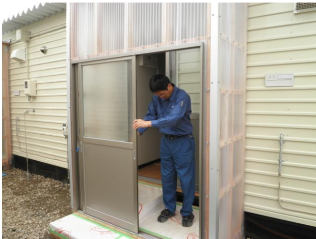
写真-6 二本松市杉田住民総合グランドでの完成検査の様子（玄関扉の作動状態を検査）
