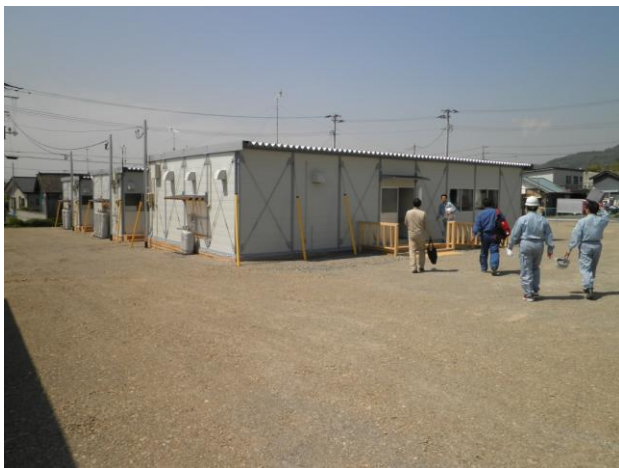
写真-1 福島市桑折町桑折駅前の仮設住宅
