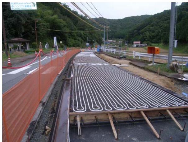
写真-3 施工状況 (放熱管敷設)
