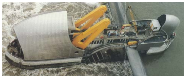
図-4 テムズバリア開閉装置部
