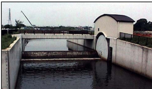
図-11 広口池南水門（下流から見る）
