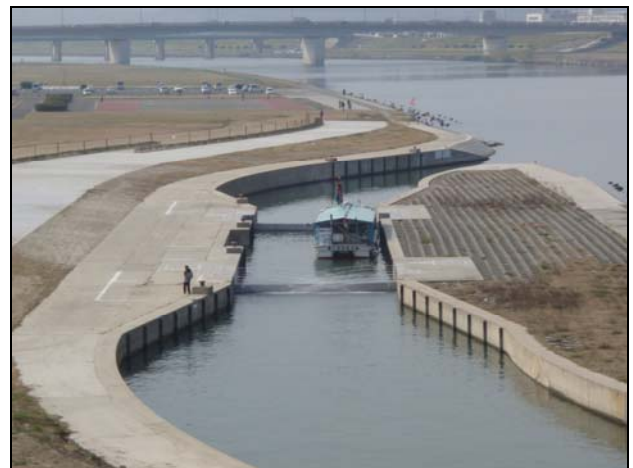
図-17 くるめ舟通し全景（上流から見る）
