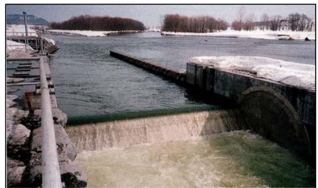
図-10 永山取水ゲート（下流から見る）
