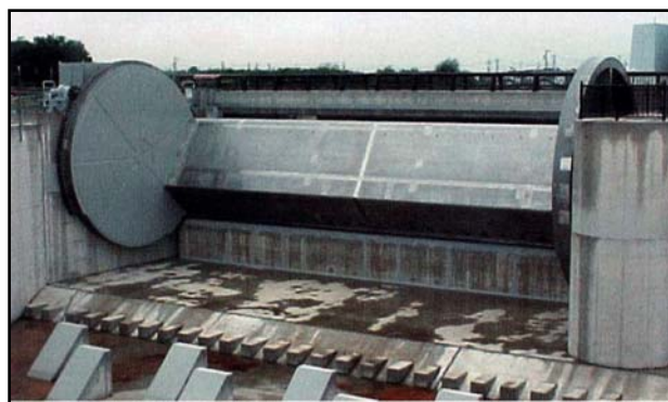
図-12 4号放水路水門（下流から見る）
