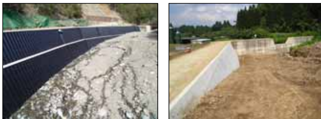
写-9 導流堤の施工事例
