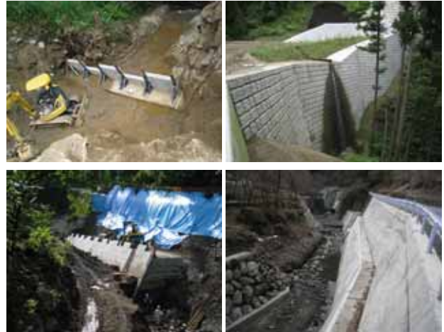
写-10 護岸・擁壁の施工事例
