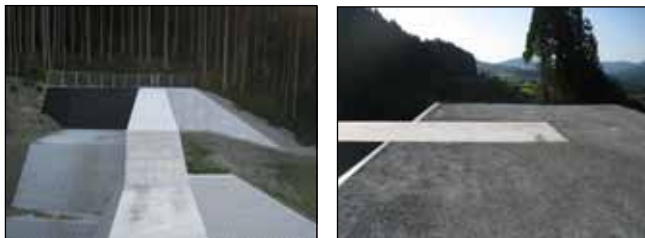
写-8 人工地山の施工事例
