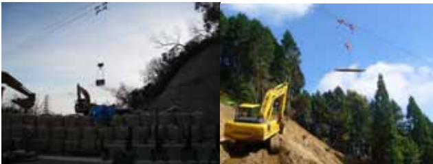
写-1 索道による施工例
