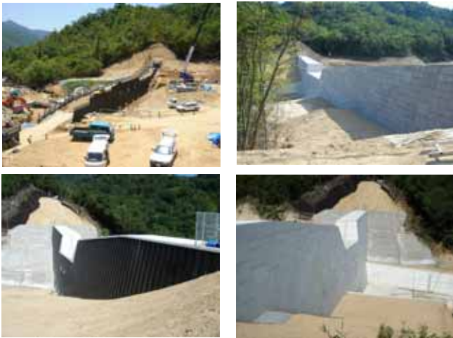
写-7 中国地区の施工事例
