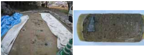
写-5 試験施工の状況
