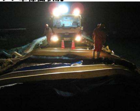
名取川(名取市)における排水ポンプ車稼働状況
