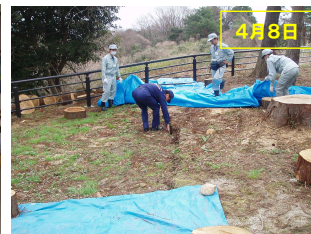
仙台市とリエゾンによる被災状況調査(仙台市西公園)
