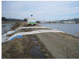
北上川河口部(石巻市)における排水ポンプ車稼働状況
