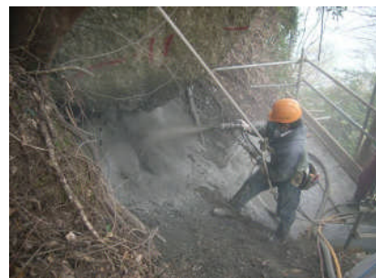
写真-2 巨石根固め吹付状況
