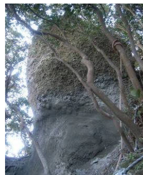
写真-3 巨石根固め吹付完了後
