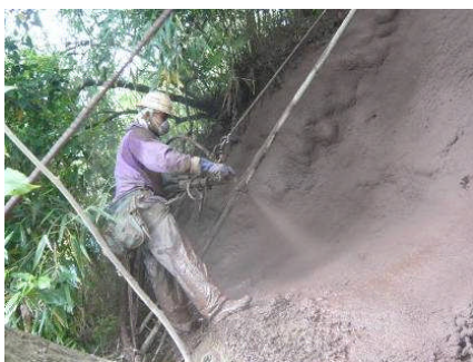
写真-5 斜面対策吹付状況
