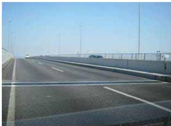
写真-7 針生高架橋伸縮装置部（A1橋台）
