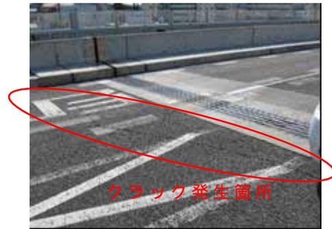
写真-8 クラック発生箇所（A2橋台）
