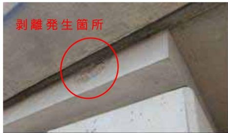
写真-12 底版側面剥離発生箇所
