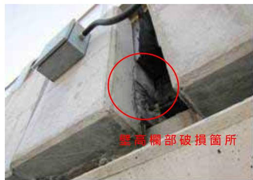
写真-9 壁高欄破損箇所
