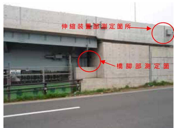
写真-5 振動測定箇所（橋台部）
