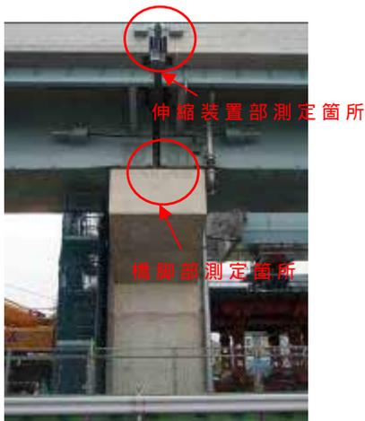
写真-6 振動測定箇所（橋脚部）
