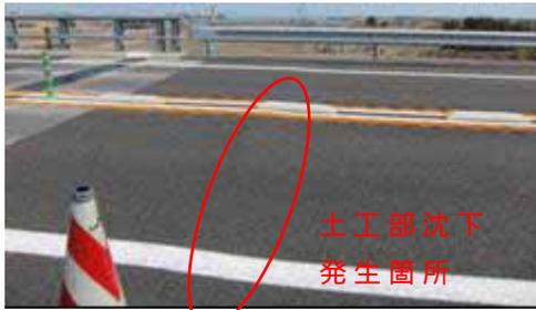
写真-11 鏡川橋沈下発生箇所
