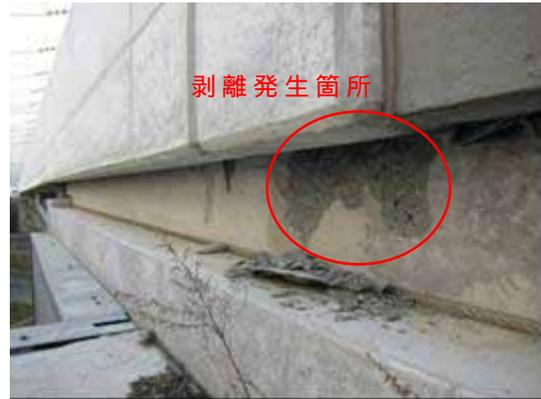
写真-15 底版側面剥離発生箇所
