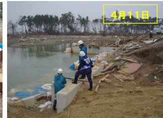
仙台市とリエゾンによる浸水現状調査(井土浦川河口付近)
