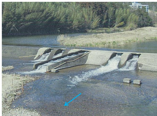
図-9 施工前の状況
