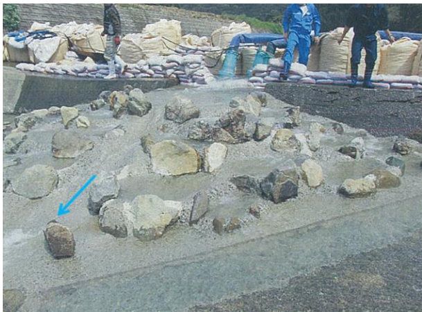
図-6 施工後の状況（下流より）
