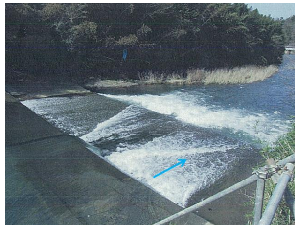
図-4 施工前の状況（上流より）
