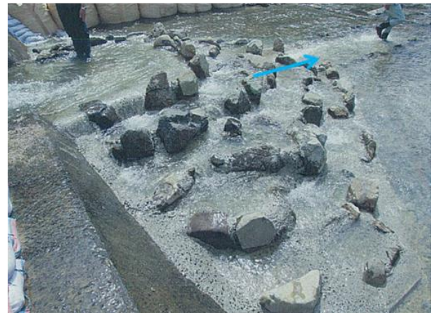
図-5 施工後の状況（上流より）
