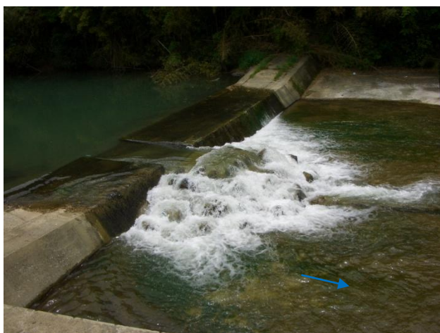
図-7 施工後全景
