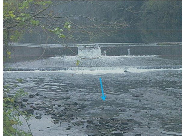
図-3 施工前の状況(下流より)
