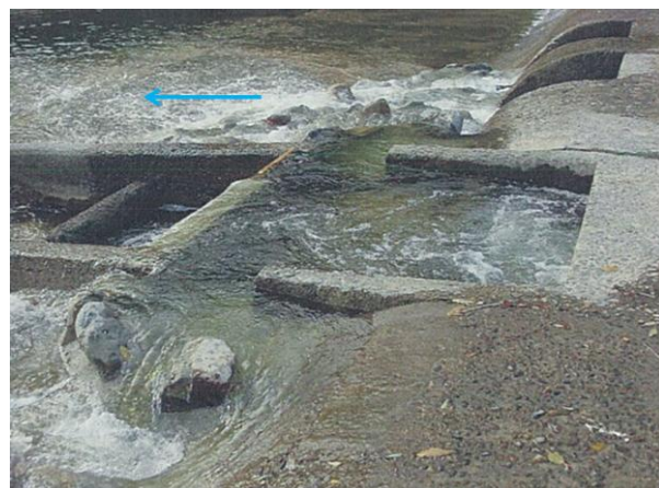
図-10 既設魚道との取り付け状況
